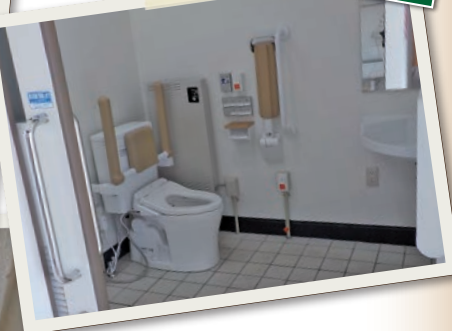
多目的トイレ
